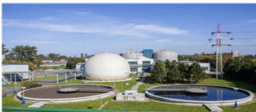
Průmyslový areál TOMA, a.s., Čistírna odpadních vod
